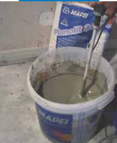
Míchání Planolitu 315 s vodou
